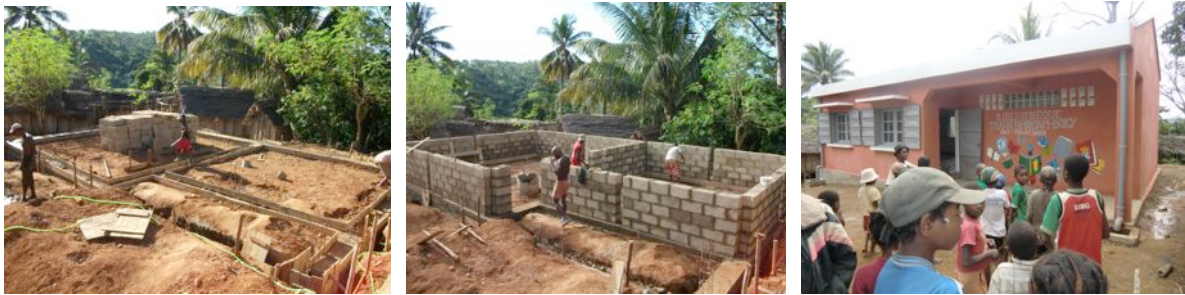
Le chantier de la bibliothèque en trois étapes...
